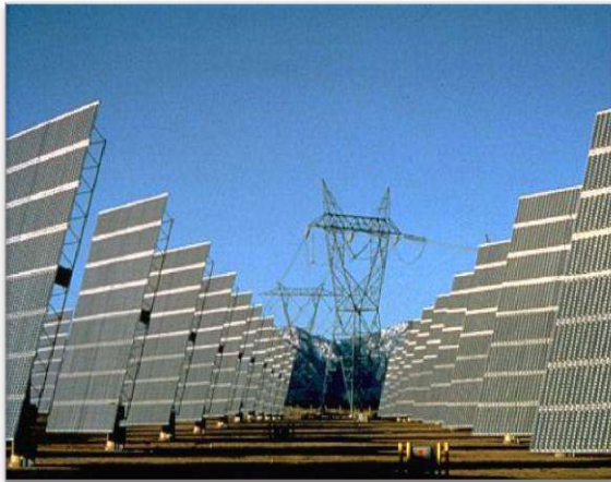
منظومة خلايا شمسية مركزية مربوطة بشبكة الكهرباء
